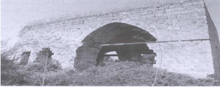
منزل حجري مقنطر . وهو البناء الوحيد الذي ما زال قائماً في القرية (آب / أغسطس ١٩٨٧) [تليل]
